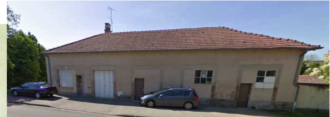
La réserve, partie gauche du bâtiment, Avenue Gambetta
